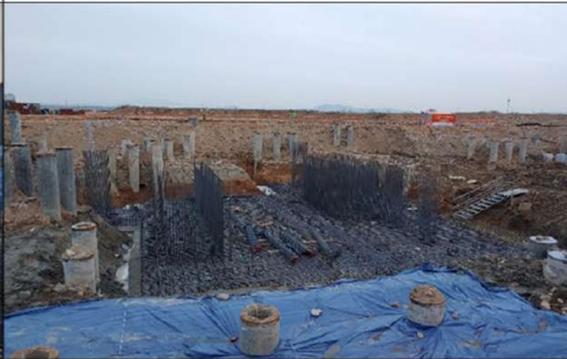
Placing foundation Steel bar in H3-P3b H3-P3b구역 기초 철근 배근
